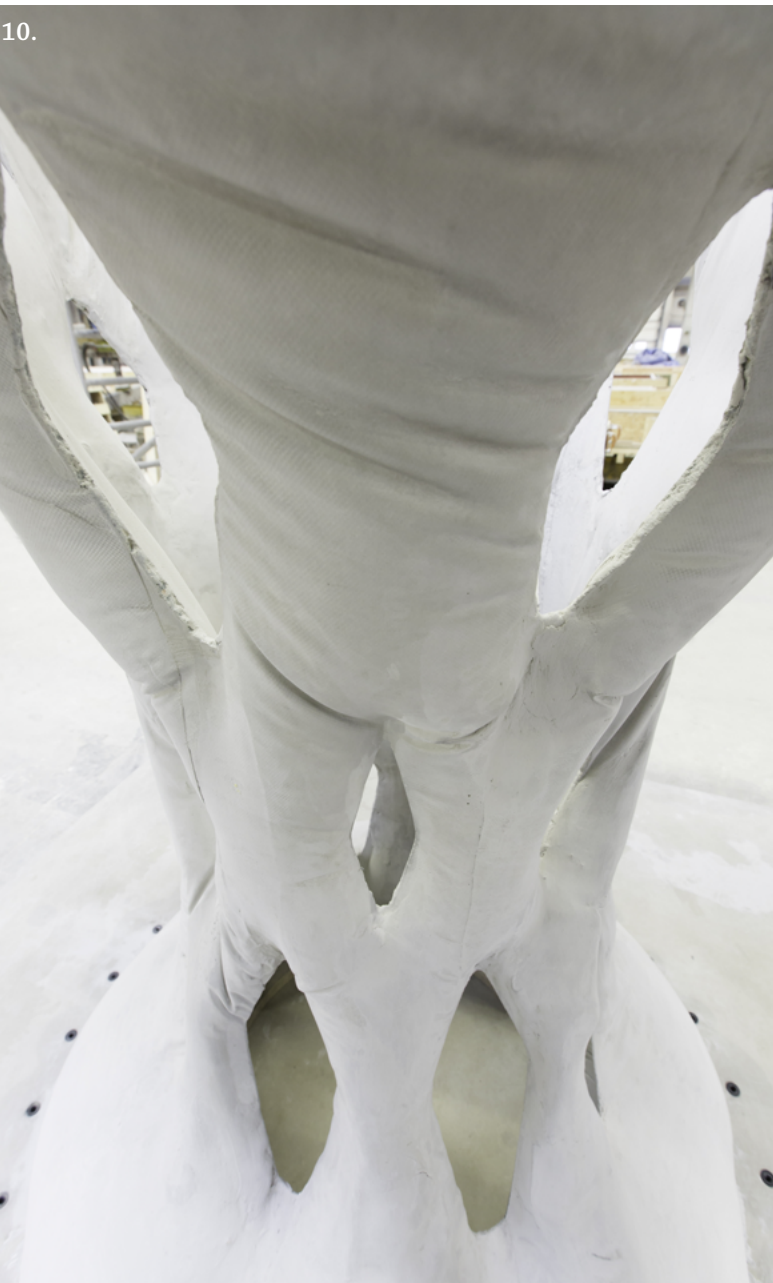
10. De vouwen, gebolde doorsneden en het tactiele oppervlak van het beton tonen de elegante vormtaal van fabric formwork. Foto: Robbert de Smet
