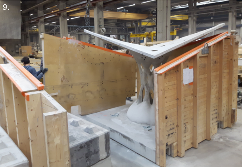
9. De houten hulpconstructie, waaraan de textiellmallen waren gespannen, worden verwijderd.
