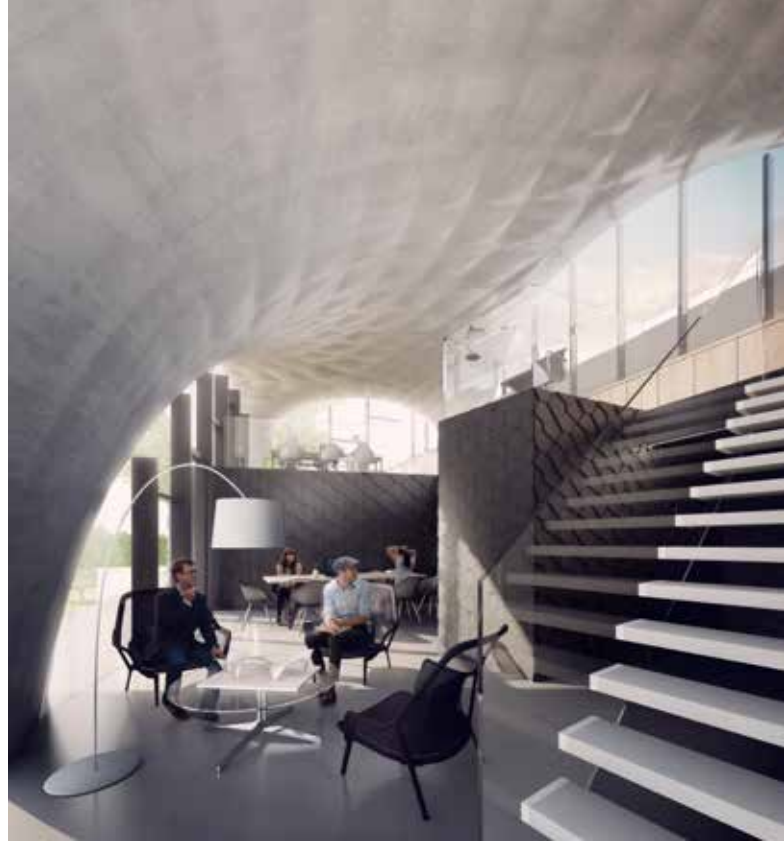
12. Interieur van NEST HiLo met kabelnetgevormd schaaldak, Dübendorf, Zwitserland. Bron: Doug & Wolf.
