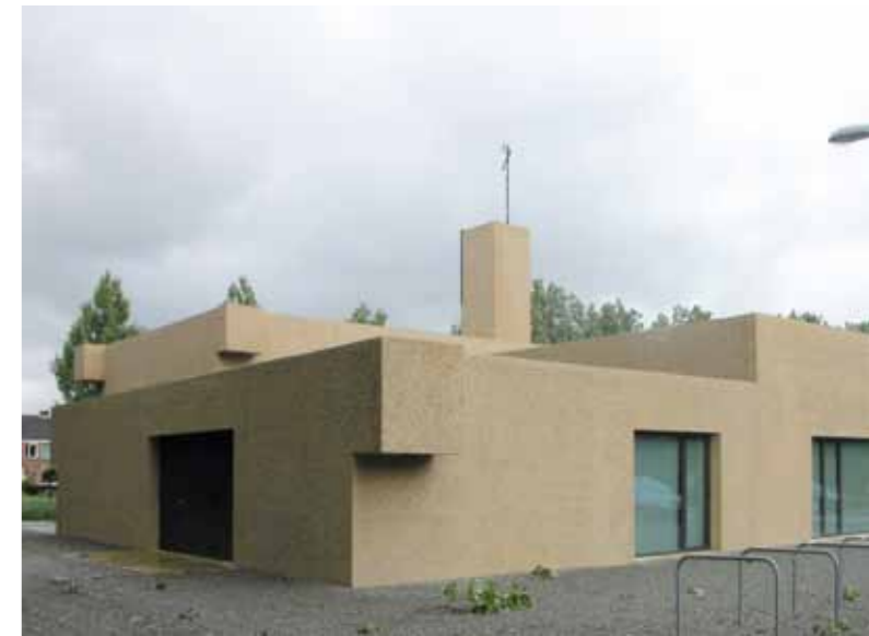
3. In Rijshout bij Schiphol is een kerkgebouw gerealiseerd waarbij alle wanden en gevels zijn uitgevoerd in gekleurd en gestraald beton. Architect: Claus en Kaan; opdrachtgever Schiphol: Real Estate. Foto: Henk Oude Kempers.
