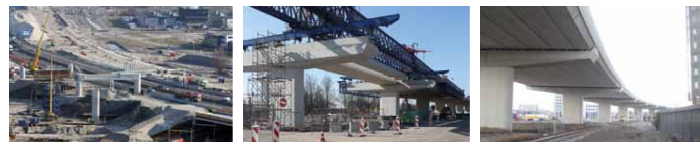
6-8. Verschillende fases van realisatie van het viaduct KW502. De steunpunten en dwarsliggers zijn in situ gestort. Met een hulpconstructie worden de voorgespannen brugdekliggers geplaatst. Nadat alle betonelementen zijn bevestigd, kunnen portalen en verlichting worden aangebracht.
