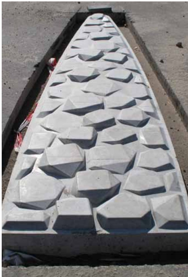
4. Een overrijdbare 'verkeersdruppel' (type Giro-druppelement), die bestaat uit één geheel, is aan de bovenzijde voorzien van een oplopende rammelfunctie. Foto: Giverbo.
