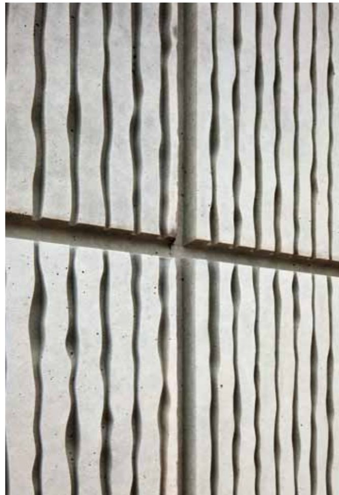
5. De geprofileerde, in het werk gestorte binnenwanden van Campus Hoogvliet, geïnspireerd op esdoornbladeren. Foto: Jan Bitter.
