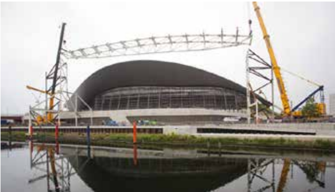
8,9. De stalen tribunes zijn inmiddels afgebroken en de vorm en materialisering van het Aquatics Centre komen steeds beter tot hun recht. De foto's, gemaakt eind juni 2013, laten de gevelmontage zien.
