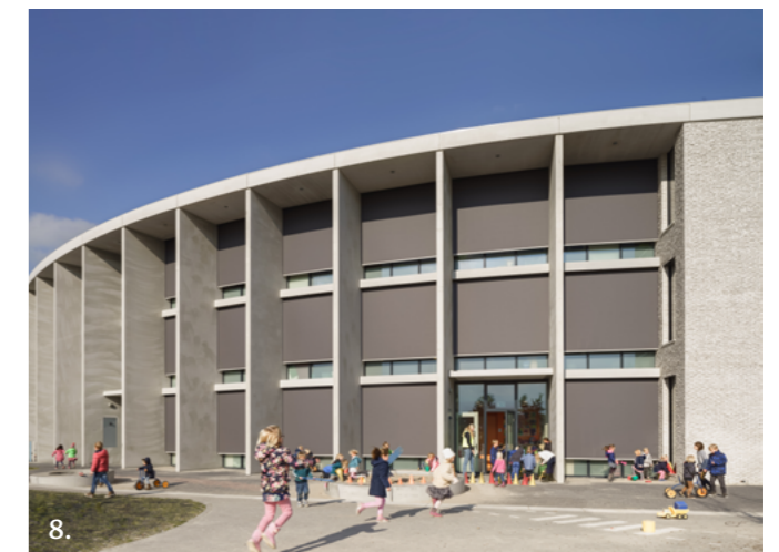
8. In deze betonschijven zijn stormvaste zonweringen geïntegreerd, die kunnen worden gebruikt in de korte periodes dat de zonnelast mogelijk te hoog is. Foto: Mark Hadden photography
