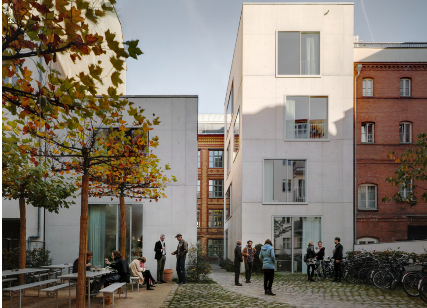
3. De vier nieuwe volumes vormen een stedenbouwkundige eenheid met de bestaande bebouwing, maar wijken met de eigentijdse keuze voor schoonbeton af van het metselwerk. Foto's 3 en 9: Simon Menges
