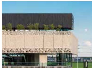
BETONNEN RANDELEMENTEN IN EEN TAKKENSTRUCTUUR Arcadis | Het viaduct Station Lansingerland in Zoetermeer is voorzien van randelementen, vervaardigd uit zeer-hogesterktebeton, uitgevoerd in een takkenstructuur.
