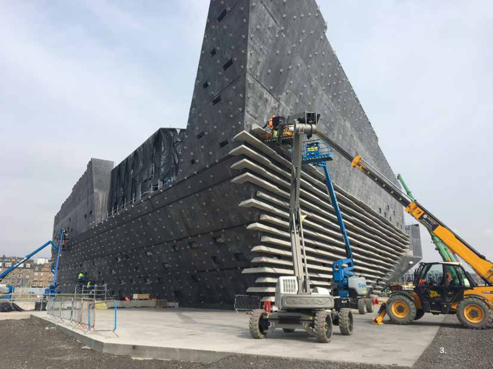
3. Bevestigen betonnen panelen op RVS-haken.
