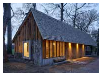
ESTHETIEK VAN TOEVALLIGHEID Hilberinkbosch architecten | Met eigen materiaal en oude technieken is een nieuwe schuur gebouwd. Het beton 'aardt' het gebouw en tilt de houten constructie boven de vochtige grond.
