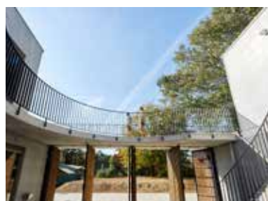
COMPACT, ROBUUST EN SPEELBESTENDIG Ark Architecten | Scouts in het Belgische Mollem hebben onderdak gekregen in nagelnieuwe lokalen in een gebouw van beton, glas en hout.
