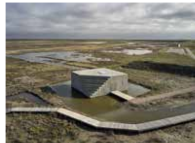
ISOLERENDE STEEN IN ZILT LANDSCHAP Rink Tilanus architecten | Regiokantoor Natuurmonumenten in Zierikzee, gebouwd met het innovatieve materiaal warmbeton.
